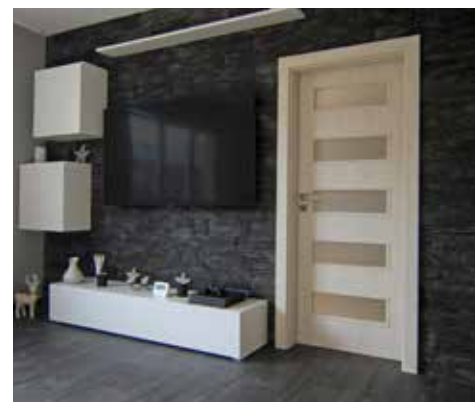
obklad kovové zárubně s novými dveřmi
